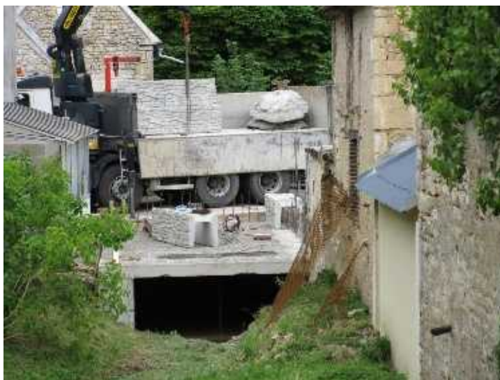
Après : passage de 3 mètres par 1,40 mètres
