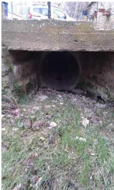
Avant : passage avec buse de 80 cm
