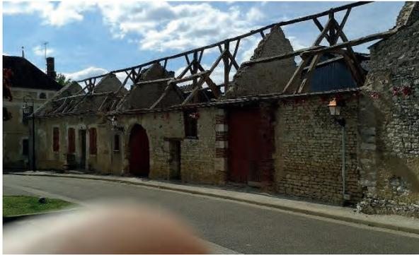
démolition, il s'est avéré que le mur de séparation entre ce bâtiment et celui de la grange Lamblin (propriété de la commune) était prêt de s'écrouler. Nous avons choisi de le démolir et de reconstruire un pignon en parpaings en laissant une ouverture de 3 mètres dans l'attente de connaître le devenir de ce local : démolition partielle ou aménagement en lieu de stockage ? Ce choix a monté la facture à 34 066 € TTC.
